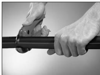
Rohr mit Schere für Kunststoffrohr durchschneiden.
