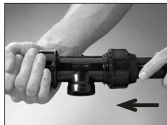
Rohrende bis zum Anschlag in den Fitting einschieben.
